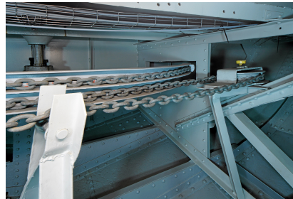
Umlenkung der Ketten. Links hinten die Achse des Ruders
